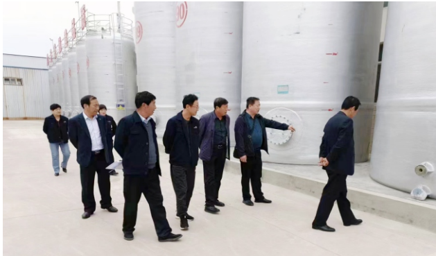
5月27日,集团武总工、编审室李主任、建安公司及施工项目部相关领导对副食公司储存罐及晒制场土建工程进行现场验收。
